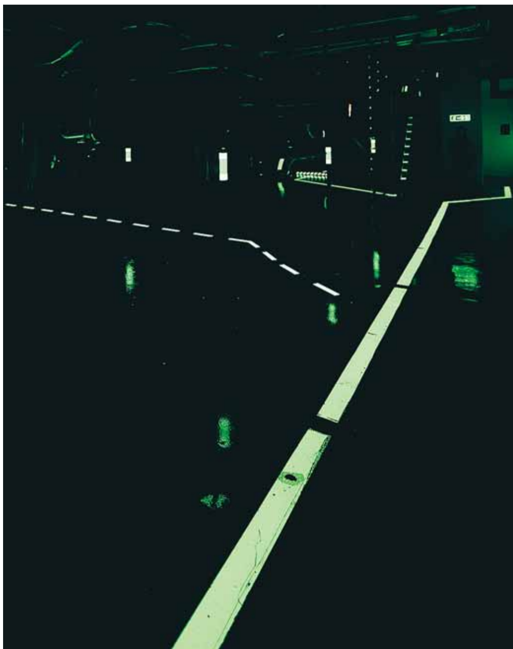
Nödbelysning. Om det skulle bli helt mörkt visar de självlysande markeringarna vägen ut.
